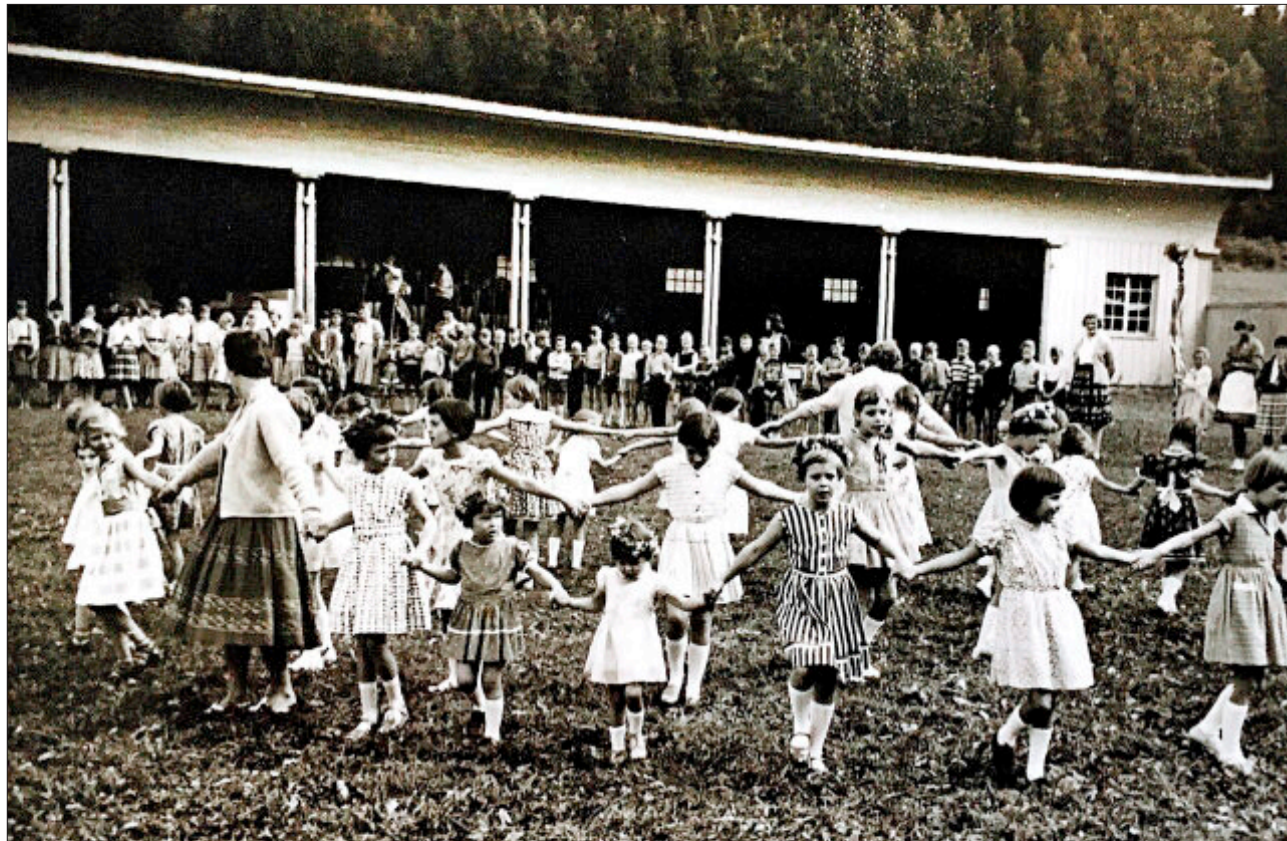
Der Schein trägt: Aufenthalte in Kurheimen wie hier in Bad Dürkheim 1959 wurden für manchen zur Qual.
